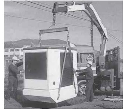
Fig. 1.28. Instalación de un CT prefabricado.
