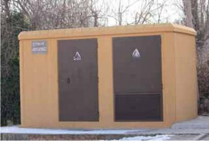
Fig. 1.26. CT prefabricado.
